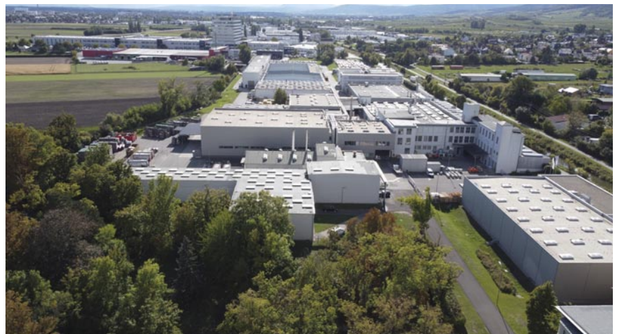
Blick auf die KLINGER Dichtungstechnik
